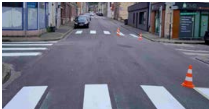
Rue du Président René-Coty, cet été, après intervention.
