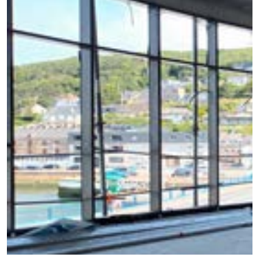
La vue depuis le 1 er étage du bâtiment.
